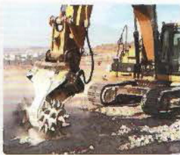
基础施工 Foundation construction
