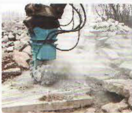
岩石铣挖 rock milling
